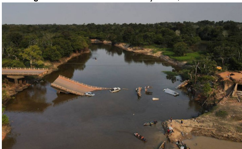
Figura 2 – Ponte sobre o rio Curuçá - AM, na BR-319.
