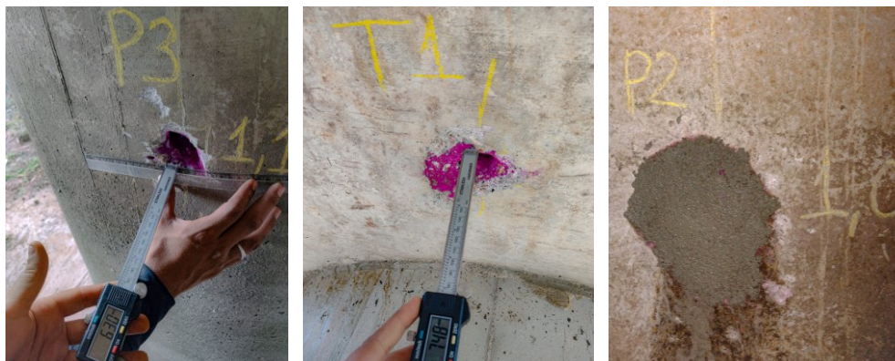
Figura 18 – Etapas do ensaio de carbonatação em diferentes elementos (conclusão).
