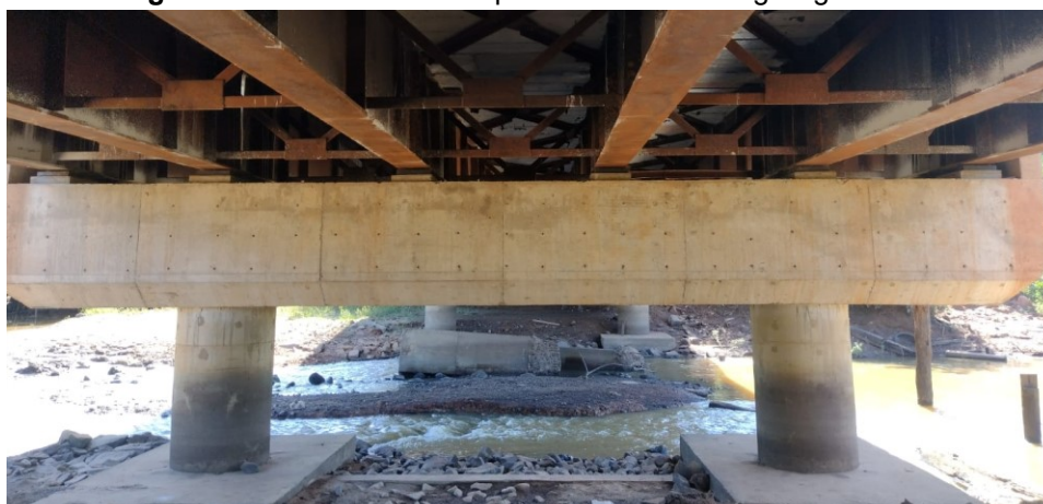
Figura 11 – Vista inferior da ponte sobre o Córrego Água Preta.
