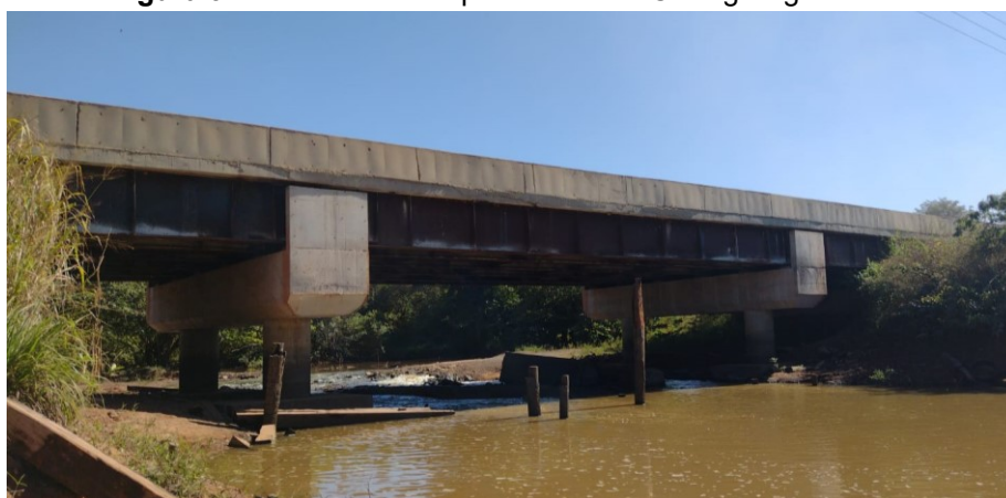
Figura 9 – Vista lateral da ponte sobre o Córrego Água Preta.
