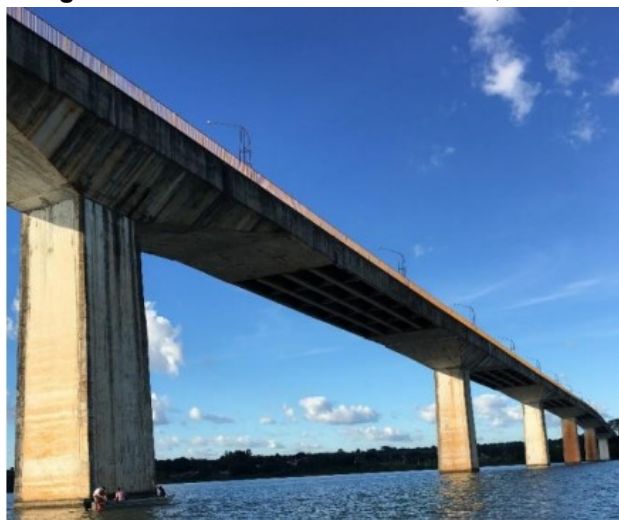
Figura 3 – Ponte sobre o rio Tocantins, TO-255.
